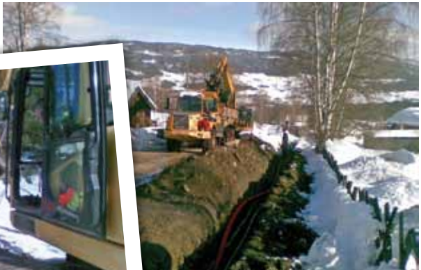
3000 meter gammel høyspent ned i bakken, Volbu i Øystre Slidre.
